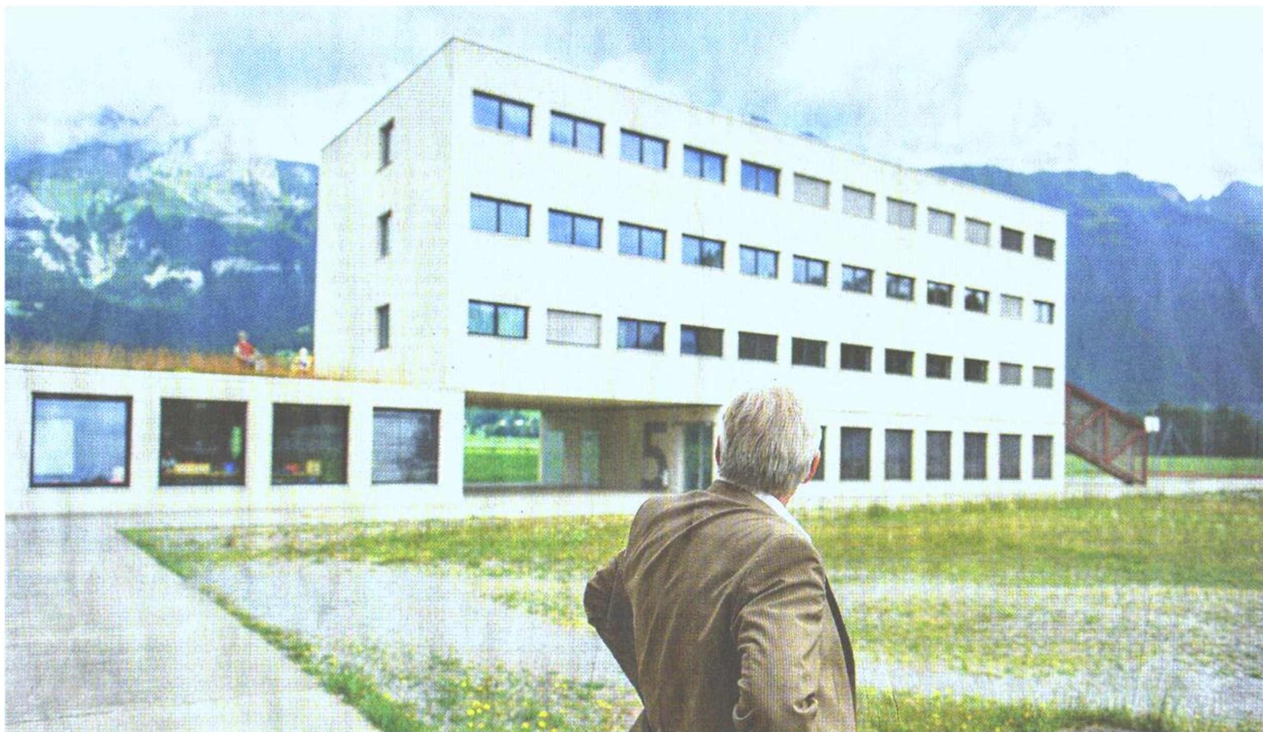
Strafanstaltsdirektor Martin Vinzens blickt zur geschlossenen Übergangsabteilung: «Das Strafbefürfnis steigt massiv an, und der Ruf nach dem Wegsperrern verunmöglicht jegliches Differenzieren.»
