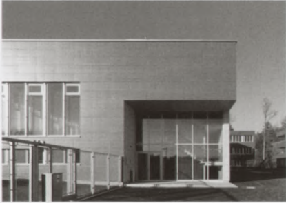
Eingang des Massnahmenzentrums Bitzi
