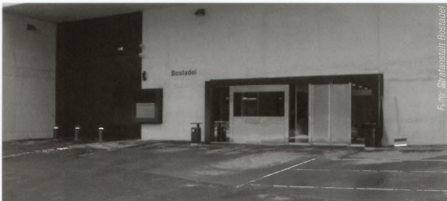
Eingangsbereich: «Wie eine Industrieanlage».
