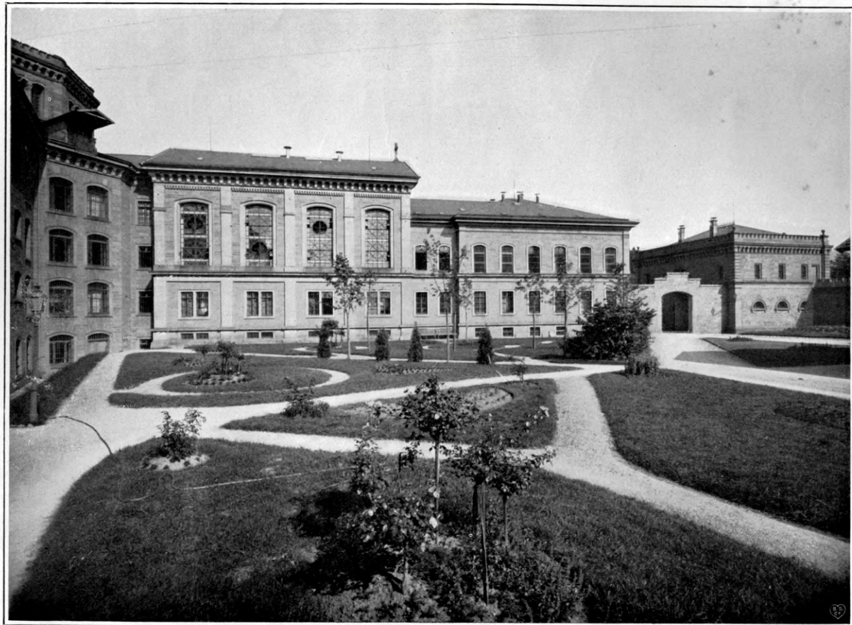
VERWALTUNGSBAU MIT KIRCHE.
